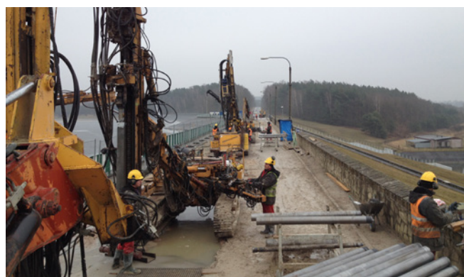
Prace na zbiorniku w Chańczy
